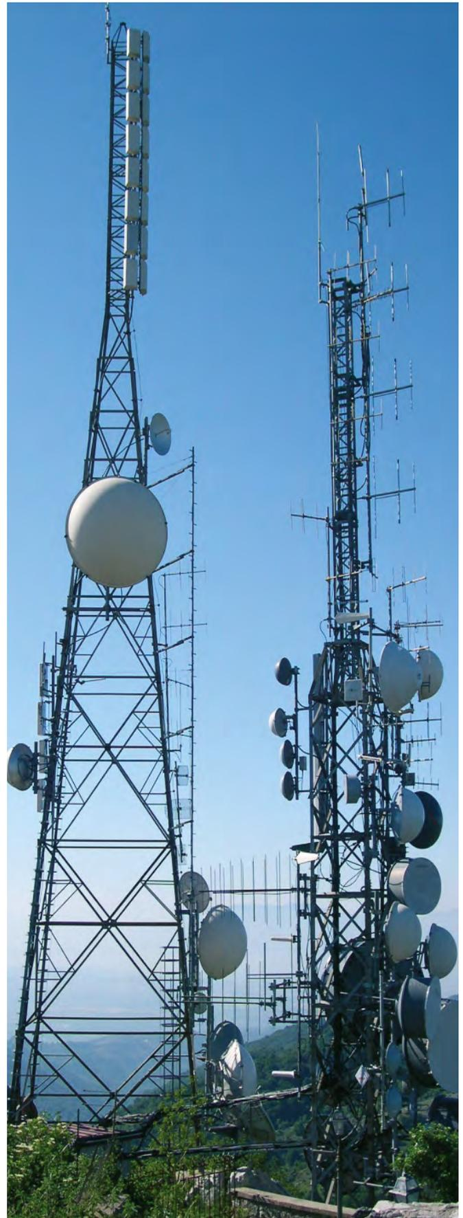
Applicazione Wi-Fi; Wi-Max; BTS - Stazioni Radio Base; Reti telefonia mobile; antenne LTE
